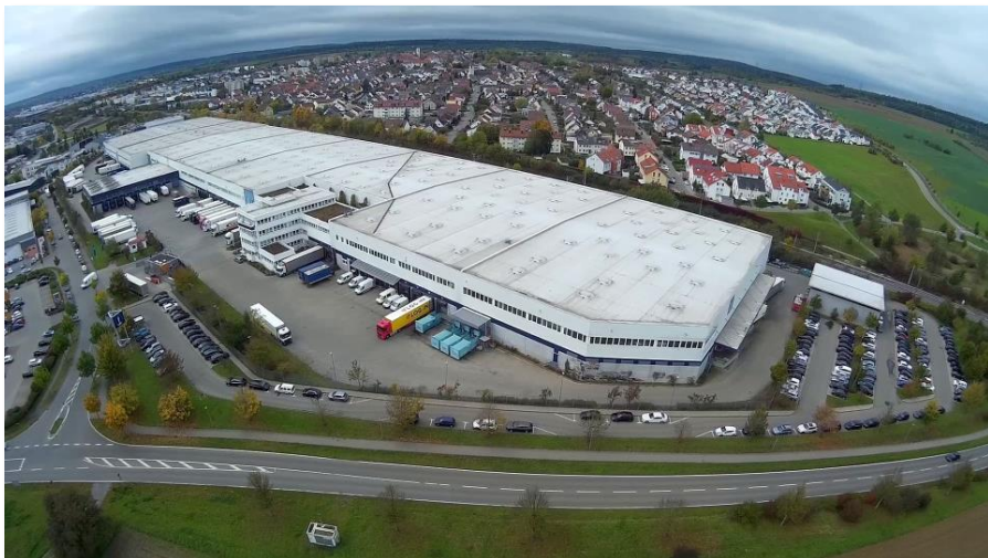
Aktuelle Luftaufnahme des neuen Landverkehrs-Terminals in Gärtringen
